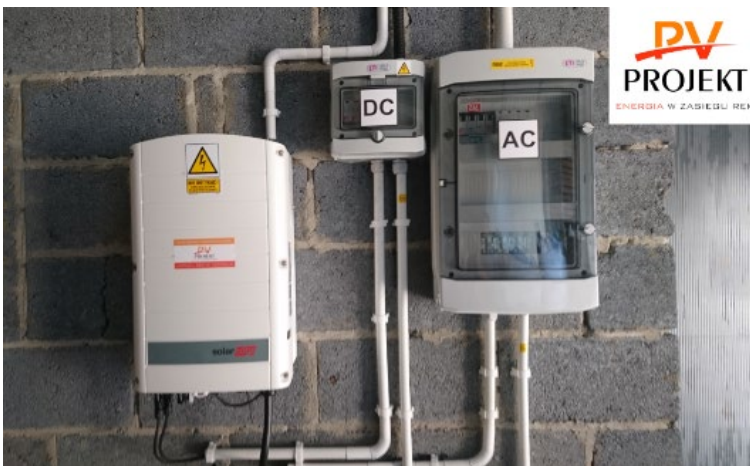
Ryc. 13. Przykład przyłącza falownika
